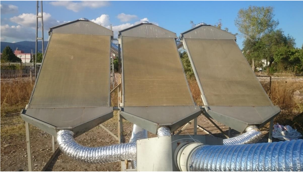
Şekil 4.4. Isıl enerji depolama sistemine entegre havalı güneş kolektörleri.
