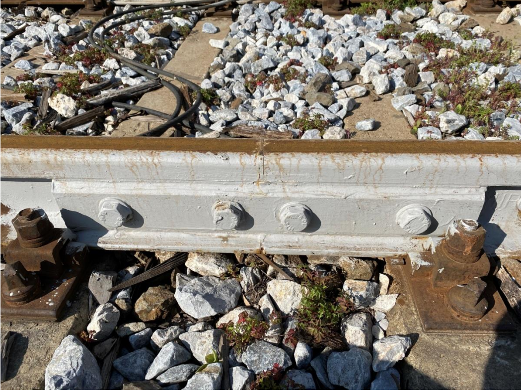
Şekil 2.8 Cebire ile yapılan ray bağlantısı
