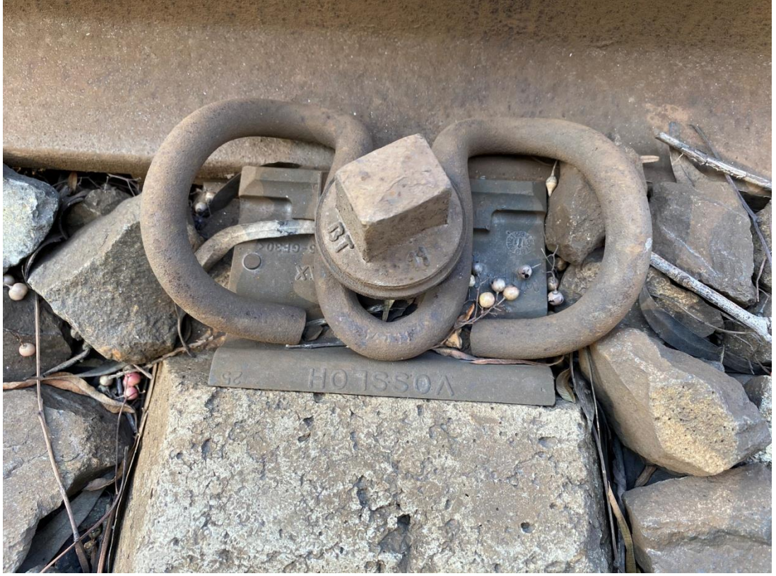
Şekil 2.7 Gergi kısıkaçı ve tirfon
