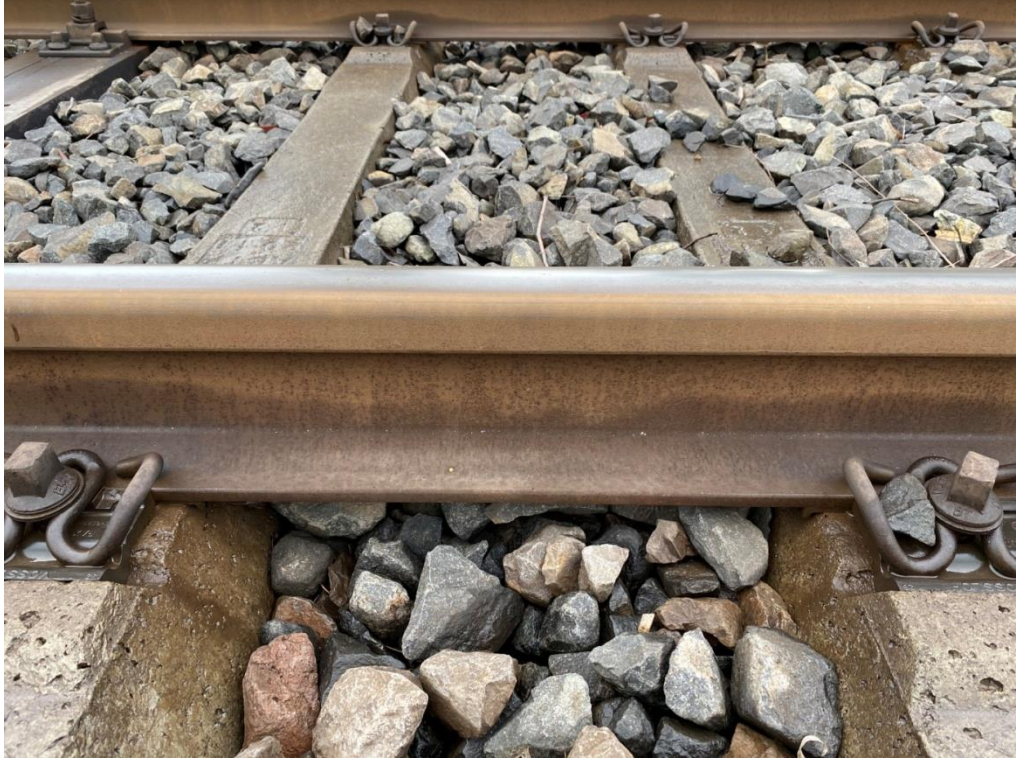
Şekil 4.3 Ray bloğu parçası
