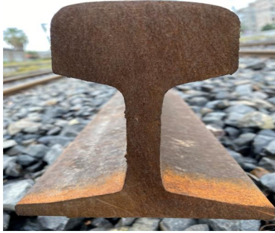
Şekil 4.4 Ray bloğu parçasının kesiti
