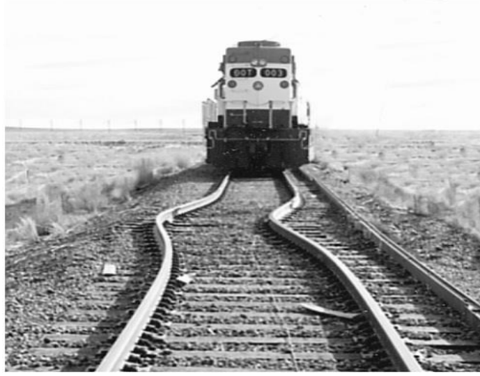
Şekil 3.3 Demiryolunda ray burkulması (Kish ve Samavedam, 2013).
