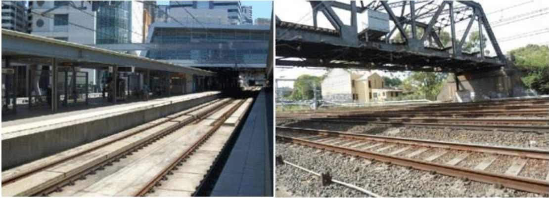
Şekil 2.1 Balastlı ve balastsız hat (Kaewunruen and Remennikov, 2016)
