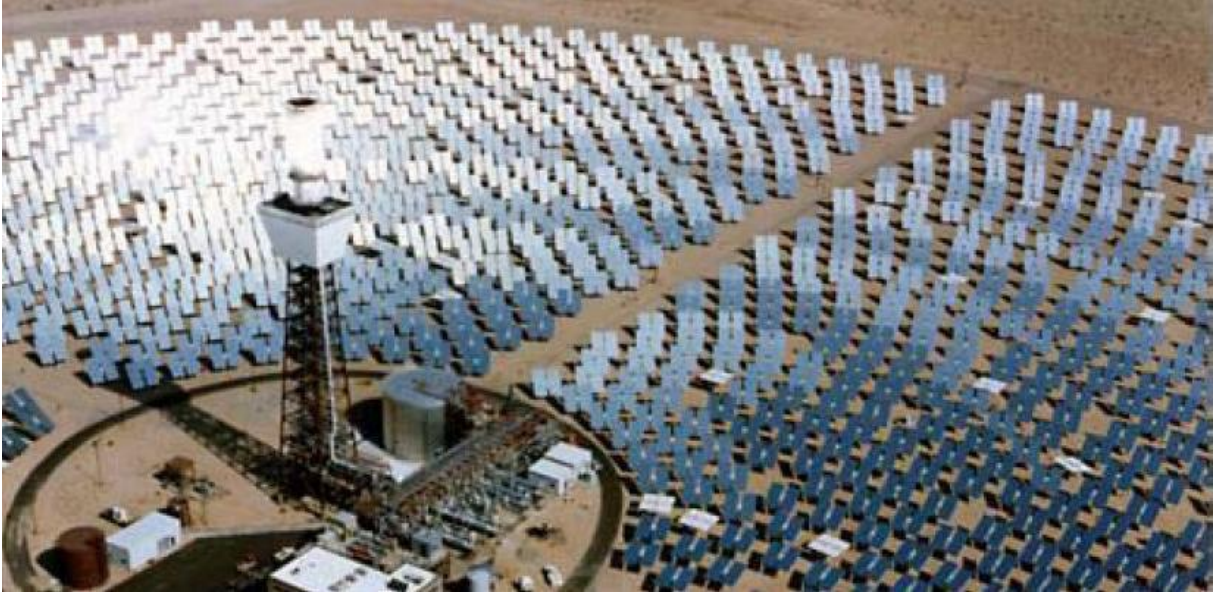
Şekil 3 Kule tipi termal güneş çevrim santralleri
