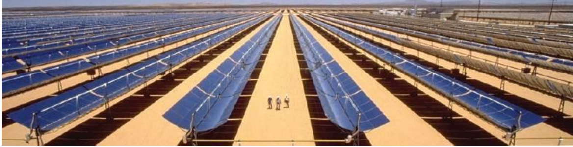
Şekil 5 Parabolik Oluk Kollektörlerle Elektrik Üretimi üzerine örnekler
